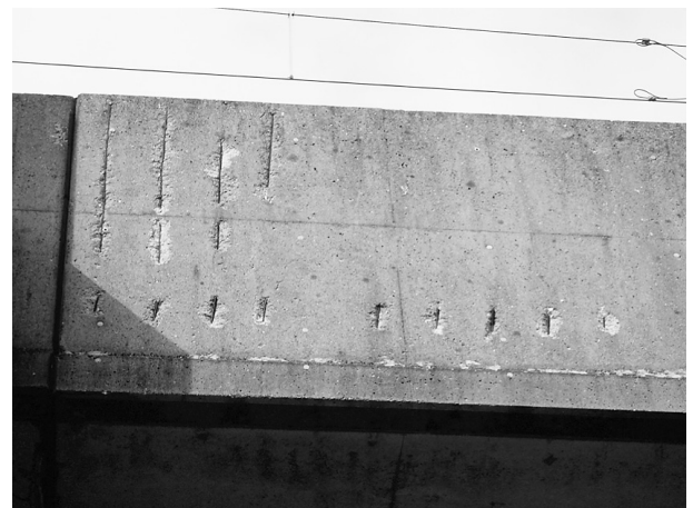
図-1 鉄筋露出写真
