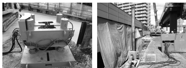
図-2 パイプラー及び引抜き状況
