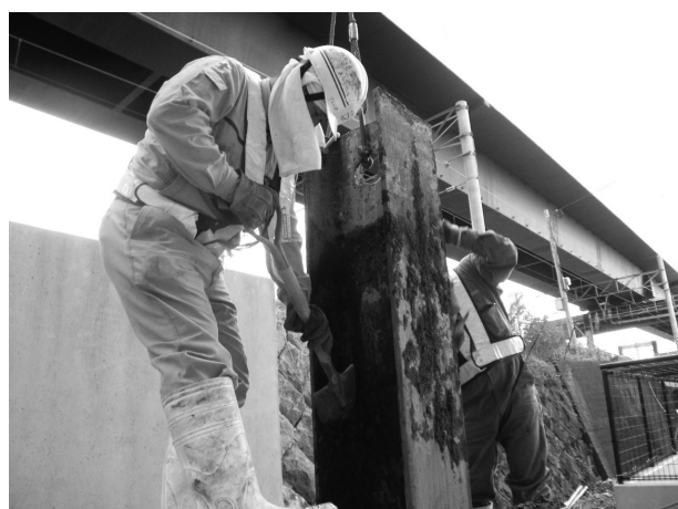
図-3 付着土撤去状況
