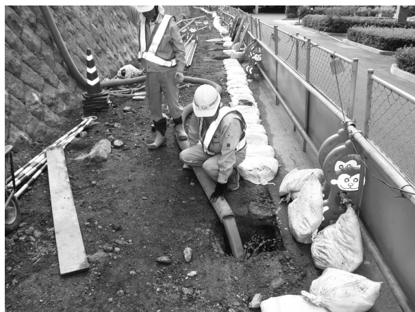
図-4 流動化処理土流入状況
