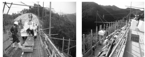
図-6 荷卸し状況写真
