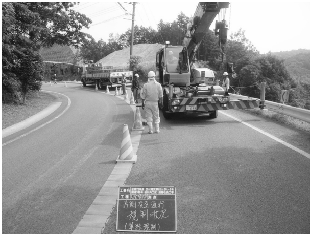
図-3 規制状況写真（アンカー工）
