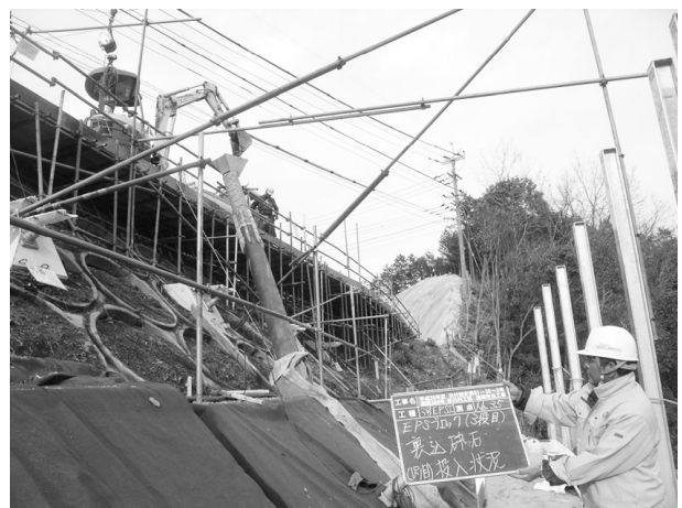
図-7 砕石投入状況写真
