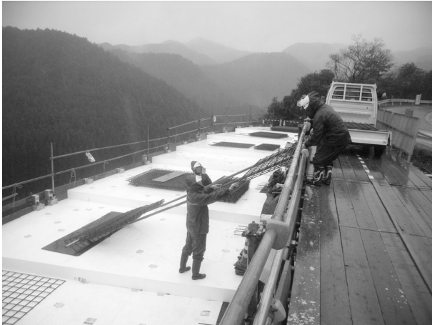
図-8 鉄筋などの荷卸し状況写真
