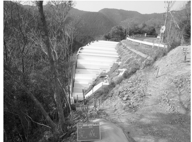
図-9 完成写真（全景）
