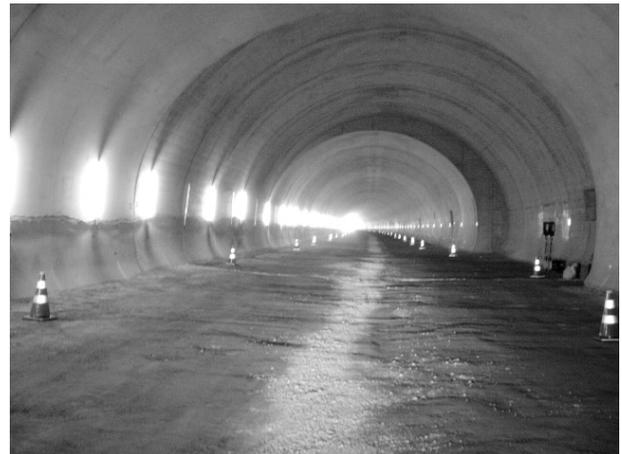
図-2 トンネル内蛍光灯照明を5m間隔に設置
