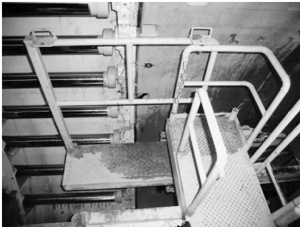
図-4 スライド式作業足場
