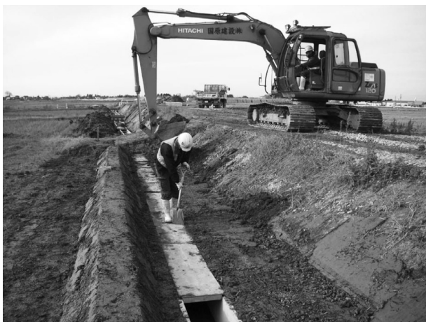
図-3 合板足場板を使用した作業状況 (BF-II 400)
