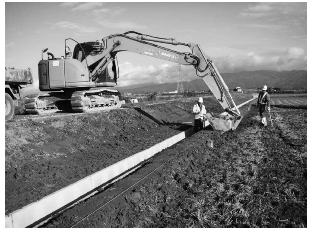
図-1 排水路施工状況
