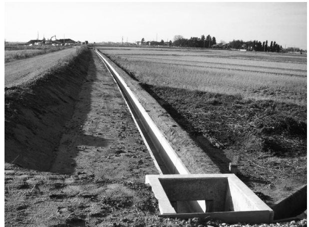
図-4 畦畔仕上げ完了 (BF-II 400)
