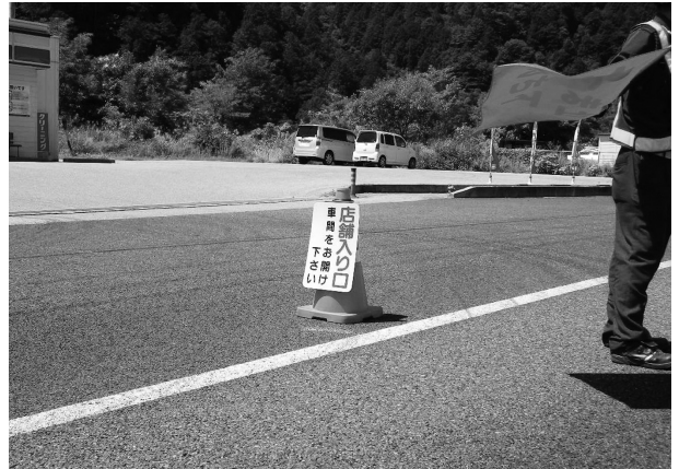
図-5 誘導員、標識設置
