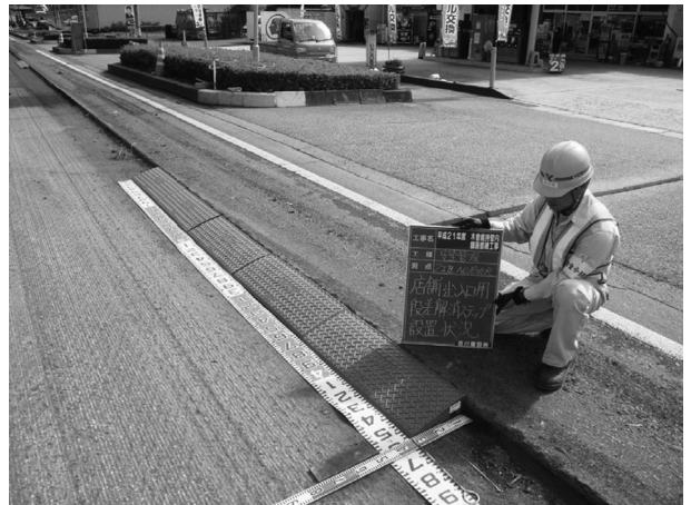
図-6 段差解消ステップ設置
