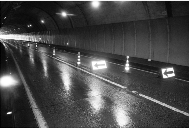
図-2 トンネル内保安施設設置状況
