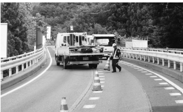
図-4 交通誘導員配置状況
