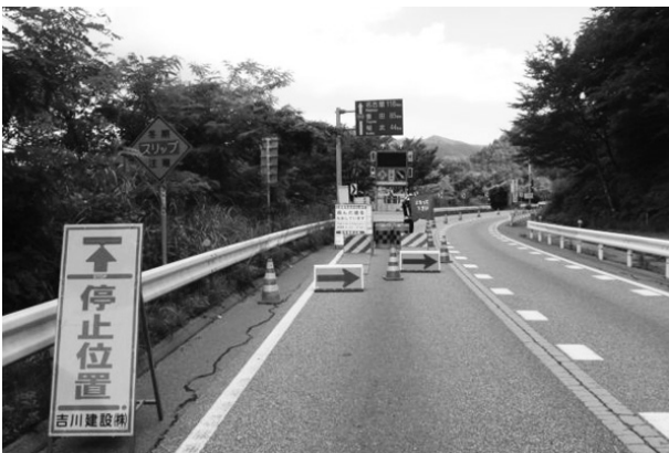
図-3 保安施設設置状況
