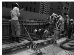
図-5 コンクリート打設
