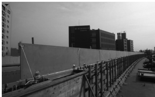
図-4 防護設備取付状況
