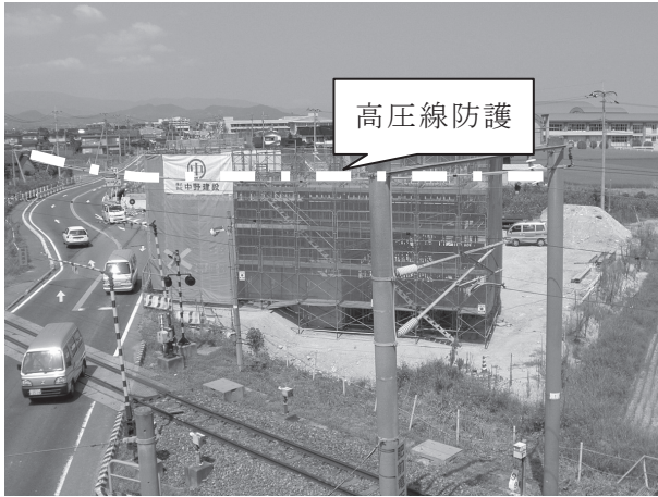
図-5 高圧線防護
