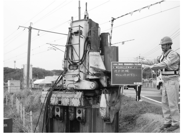
図-6 鋼板打設状況
