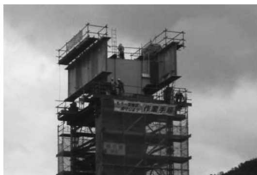
図-8 剛結部据付状況
