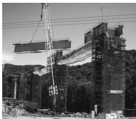
図-6 中央径間架設状況
