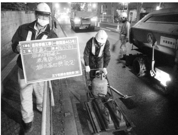
図-3 排水帯加熱状況
