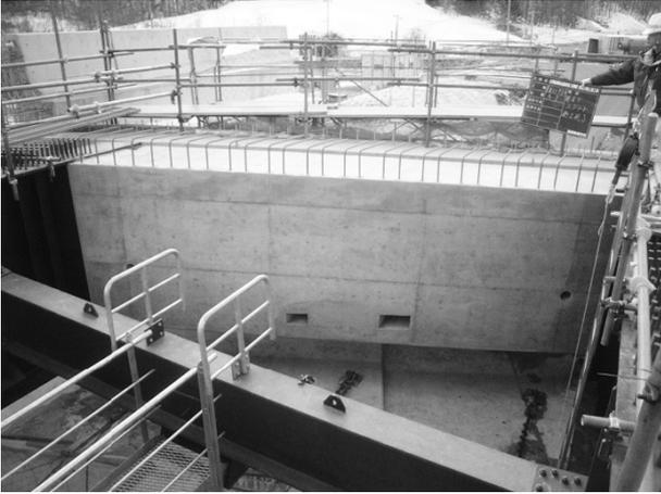
図-4 巻立てコンクリート完了
