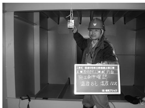
図-5 箱桁内面の温湿度確認状況
