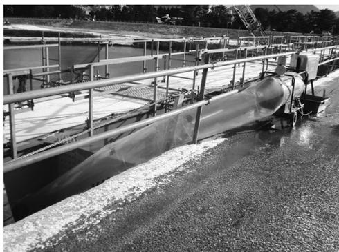
図-3 ジェットヒーターによる暖風送り込み状況
