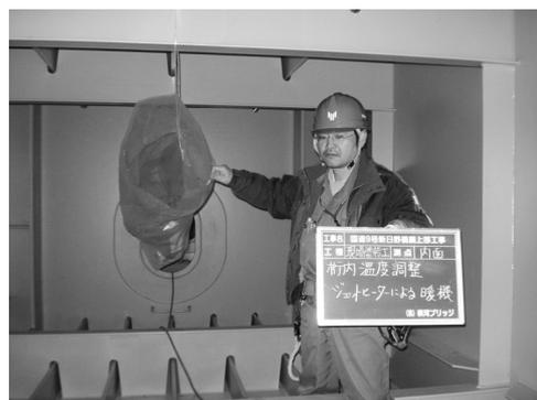
図-4 箱桁内へ暖風送り込み状況
