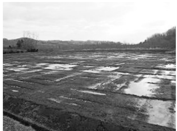
図-5 暗渠排水工事完了
