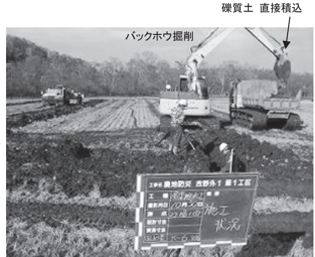
図-4 掘削土砂積込状況
