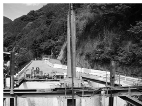
図-3 導杭・定規設置
