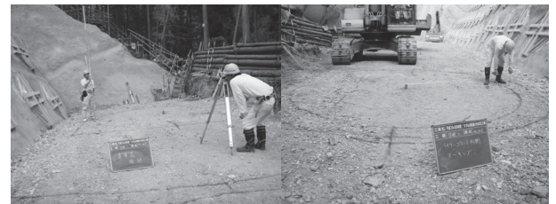
図-1 ライナー設置箇所のレベリング・マーキング
