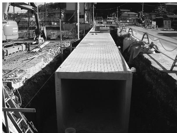
図-5 規定高さに布設され甲蓋敷された大型水路状況
