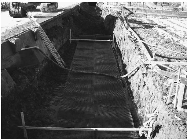
図-3 大型水路床付け面ジオグリッド敷設状況
