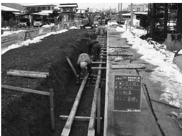
図-4 自由勾配側溝梯子胴木連結敷設状況
