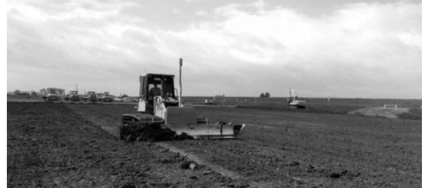
図-5 超湿地ブルドーザーによる作業状況
