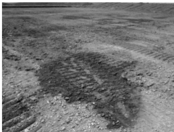
図-1 基盤に浮上った湧水
