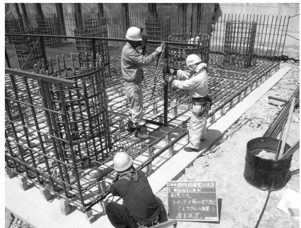
図-1 鉄筋架台組立て状況
