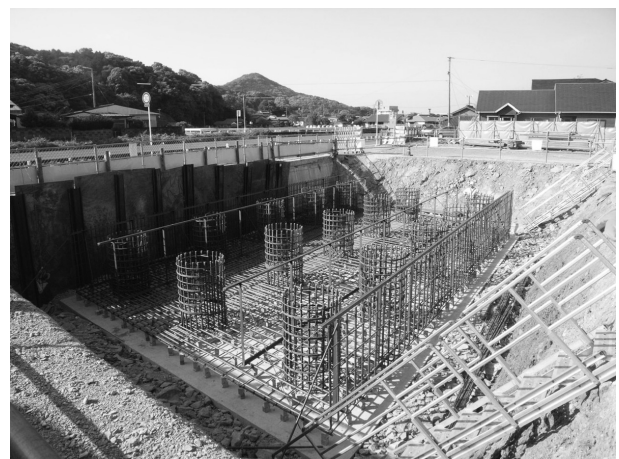
図-2 鉄筋架台組立て完了
