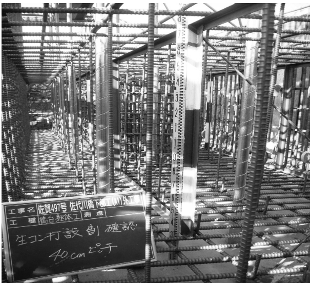
図-3 生コン打設割マーキング
