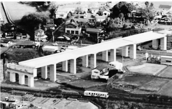
図-1 工事区間全景
