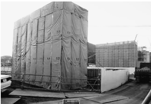
図-4 躯体全体養生状況（冬季）
