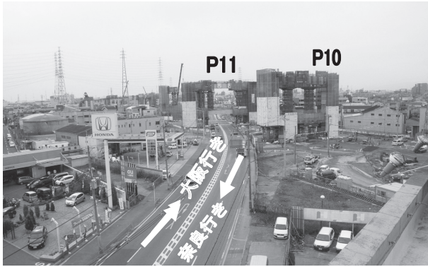
迂回路施工前
