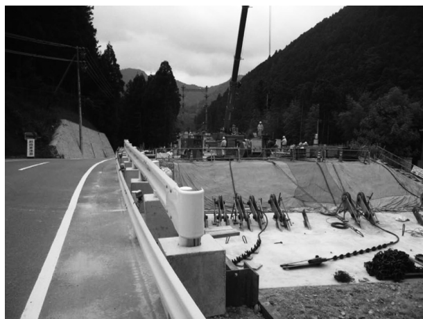
図-3 桁端ブロックの架設完了状況
