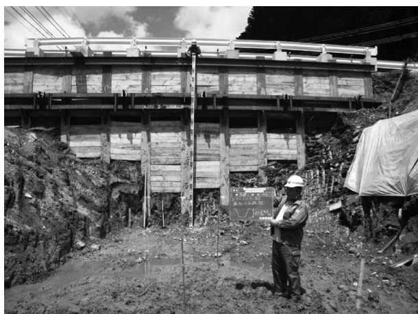
図-2 掘削面の土留め
