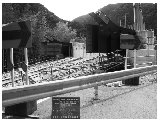
図-4 掘削部分の二重の転落防止
