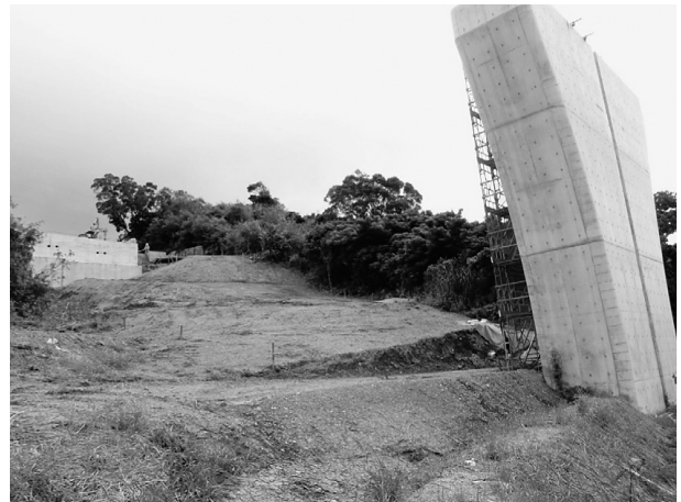
図-1 ベント設置箇所現況
