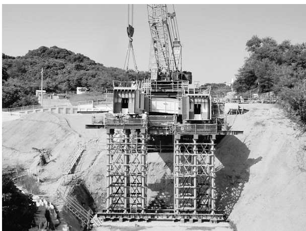
図-2 B2ベント(床掘+鉄板基礎)
