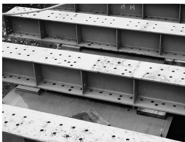
図-6 受梁の設置状況
