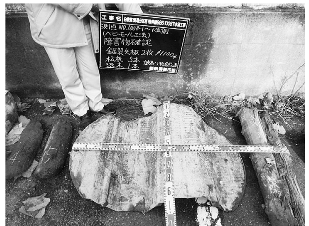
図-6 鋼矢板切取撤去完了
