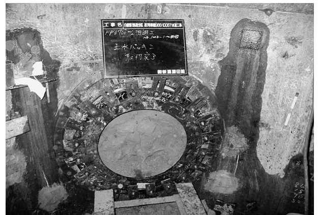
図-7 CB注入完了 (外側：鋼製さや管坑口 内側：泥水推進坑口)
