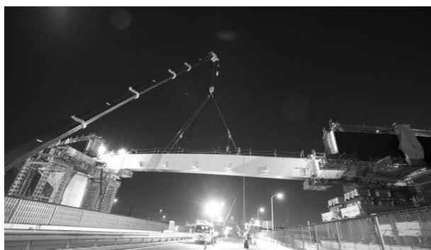
図-4 近畿自動車道上の架設 (Bランプ橋)
