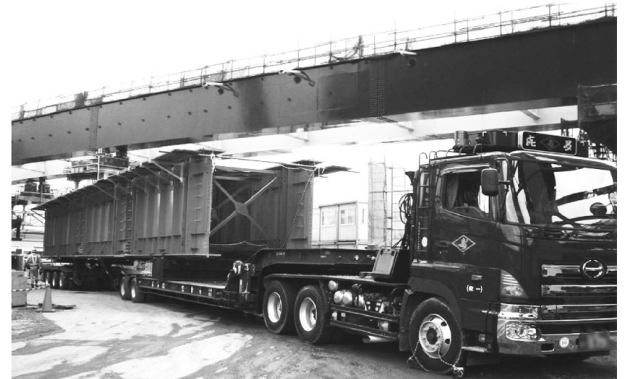
図-7 大型ベントの運搬車両
