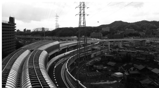
図-2 現場全景写真(完成時)
