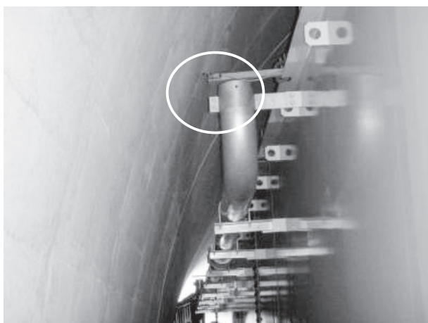
図-3 接触センサー取付状況（○部）
