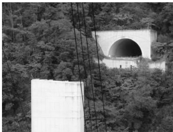
図-1 P6～A2架設地点（手前がP6橋脚）
