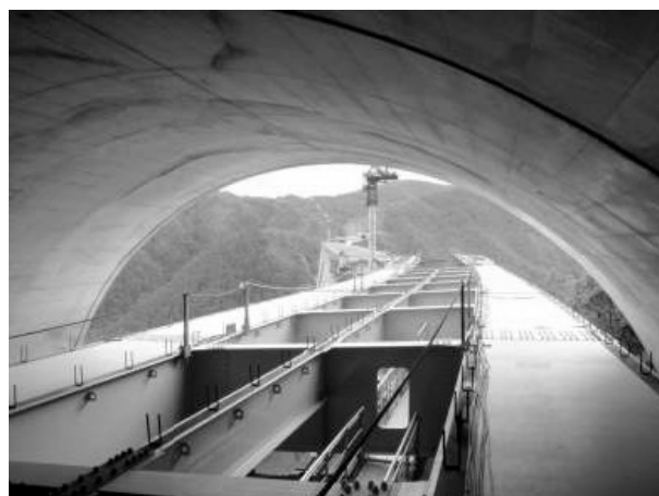
図-4 送出し状況（トンネル内より望む）
