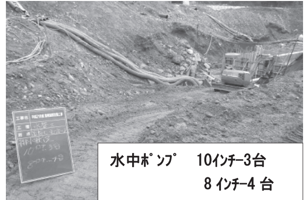
図-5 水中ポンプの設置状況
