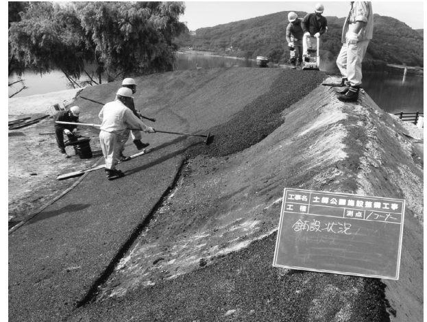
図-6 法長が長い場合の施工
