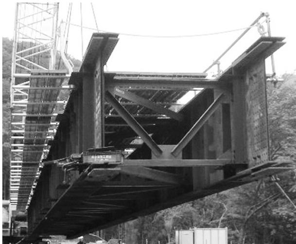
図-4 架設桁
