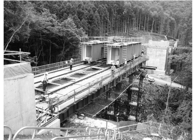
図-6 桁縦取り状況
