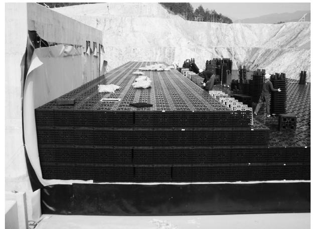
図-3 地下調整池ブロック組立状況
