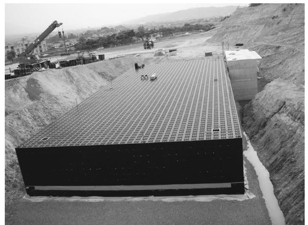
図-4 地下調整池ブロック組立完了
