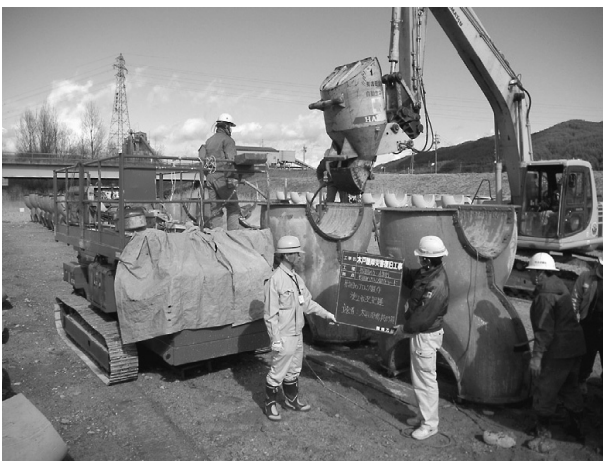
図-4 コンクリート打設状況
