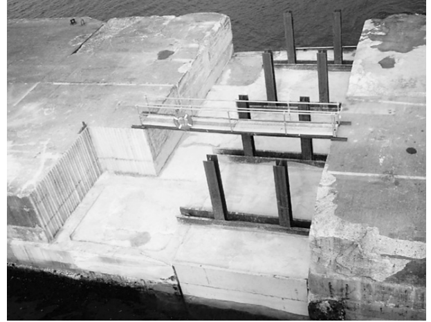
図-8 本土工 補修完了全景
