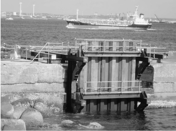
図-7 波止め工完成（港外側より）
