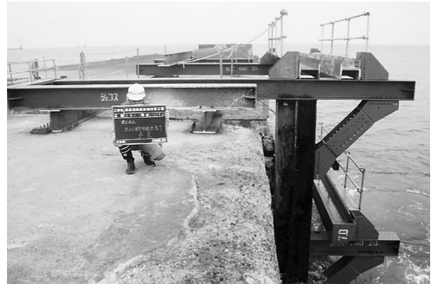
図-4 波止め導材設置完了
