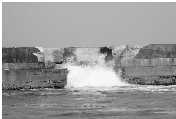
図-1 防波堤補修前
