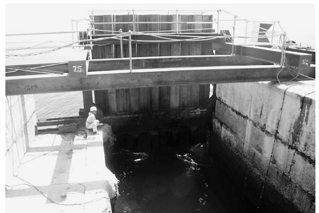
図-6 波止め工完成
