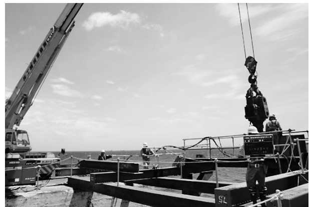
図-5 波止め鋼矢板設置状況
