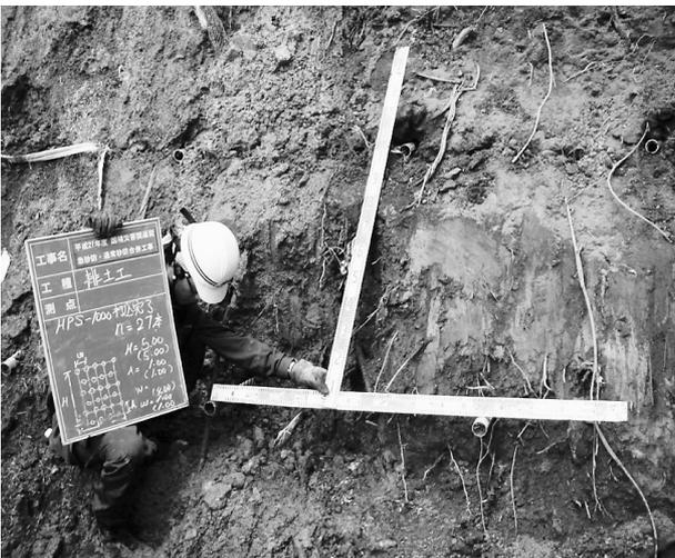
図-5 ハーフパイプ等間隔挿入状況
