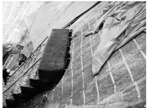
図-7 ハーフパイプからのふとん籠へ分散と法面抑止状況全景
