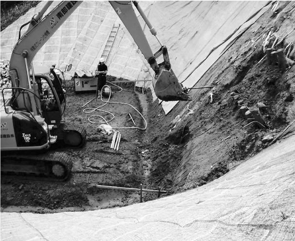
図-4 2BH0.45m<sup>3</sup>アタッチメント削岩機削孔状況
