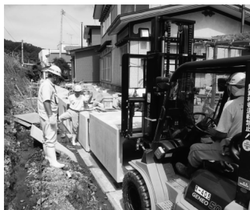
写真-3 ボックスカルバート据付け状況
