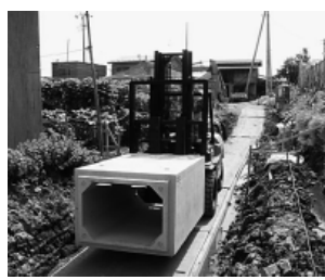
写真-2 工事用道路
