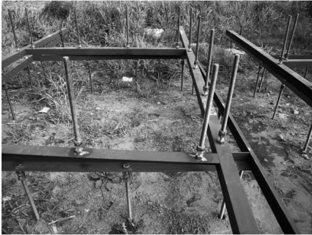
写真-1 ボルト取付状況
