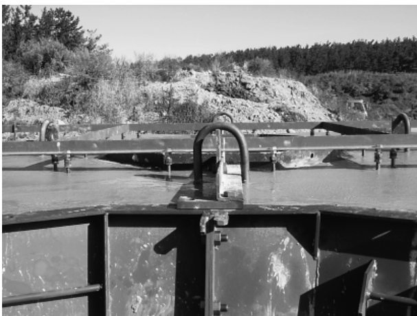
写真-2 ボルト埋込状況
