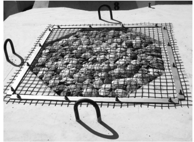
写真-3 取付完了
