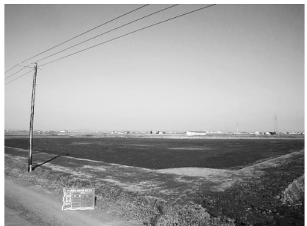
写真-3 整地完了
