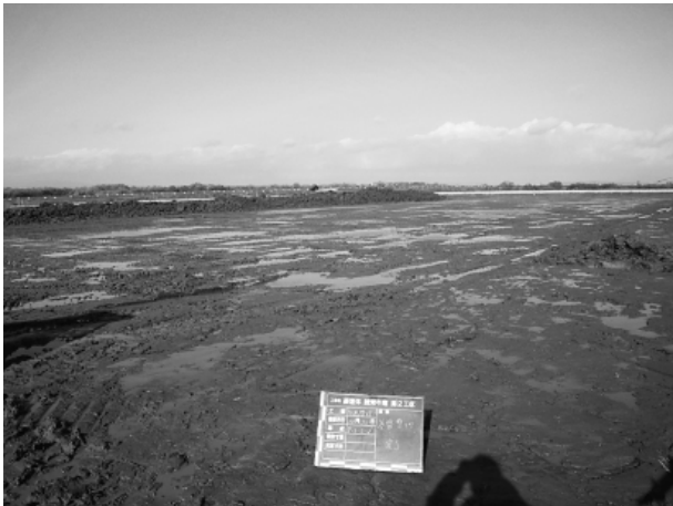
写真-1 表面水滞水状況
