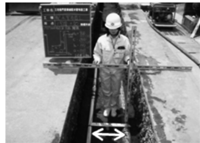
写真-5 新設ガス管との離隔
