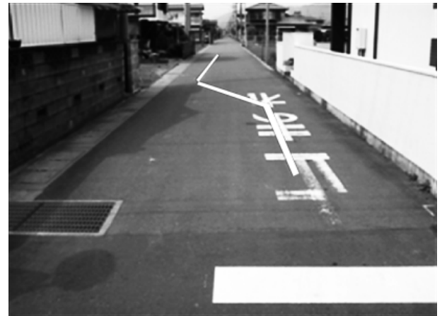
写真-2 着工前状況（終点～起点）
