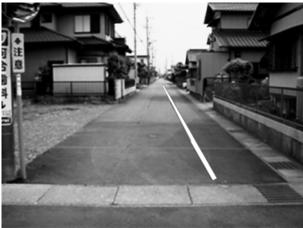
写真-1 着工前状況（起点～終点）
