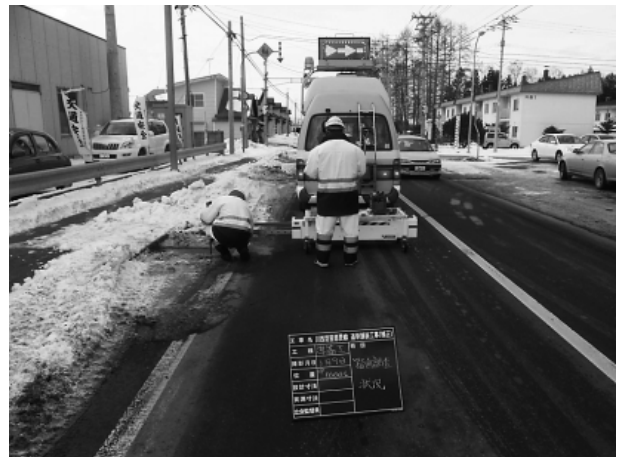
写真-2 わだち掘れ調査
