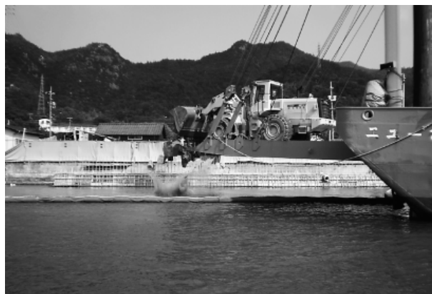
写真-3 捨石投入時
