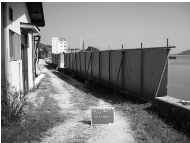
写真-2 防音シート設置
