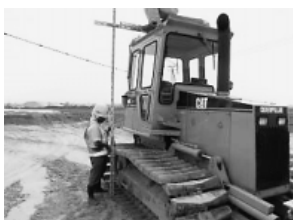
写真-5 Z座標の確認
