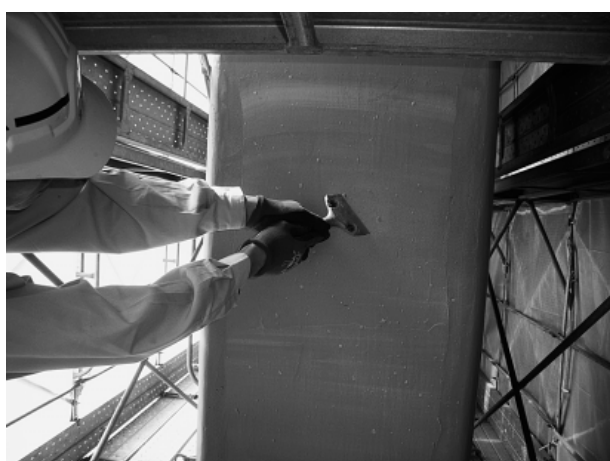
写真-3 パテ塗り1回目チェック
