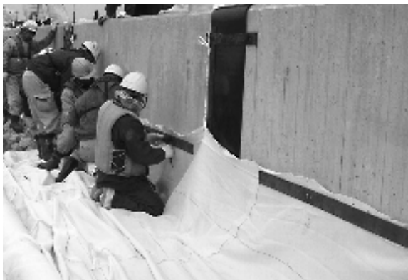
写真-1 シート端部の固定状況
