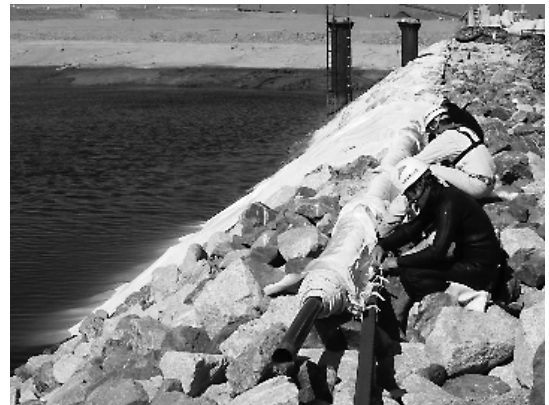
写真-2 シート設置状況
