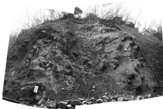
写真-3 法面保護工完了
