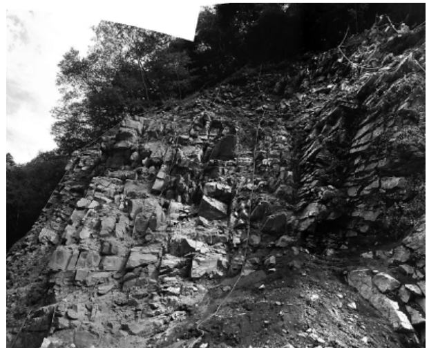
写真-1 施工前の法面状況
