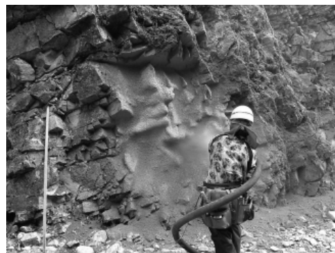
写真-2 ECOバインド吹付状況
