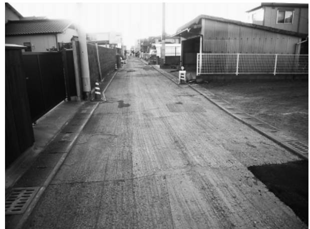
写真-3 路面切削完了
