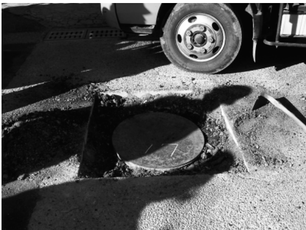
写真-2 マンホール上部撤去後
