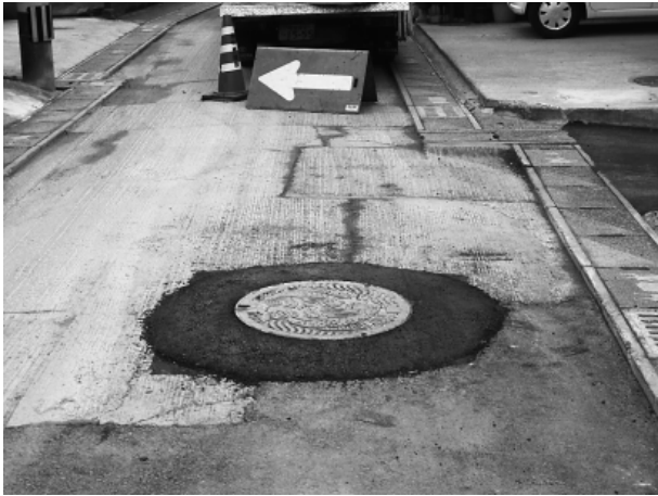
写真-1 擦り付け舗装
