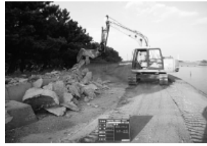
写真-4 コンクリート圧碎機
