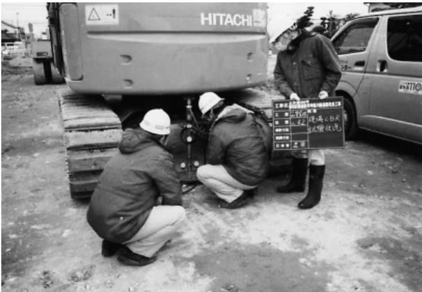
写真-2 現場C B R試験状況
