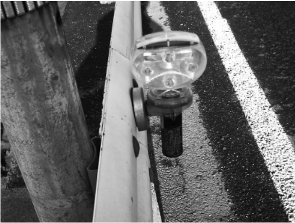
写真-2 下り線側自発光視線誘導標設置
