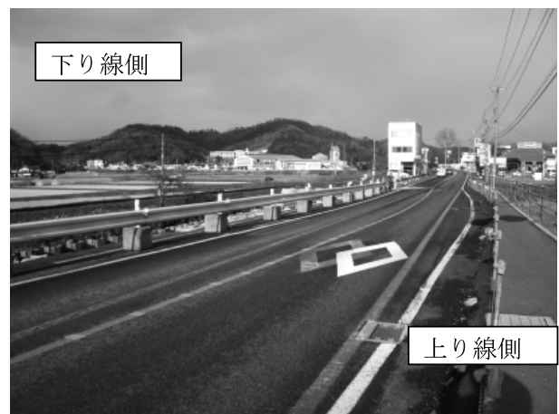
写真-1 車線変更後現場状況
