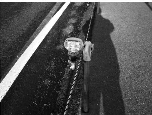
写真-3 下り線側自発光視線誘導標設置
