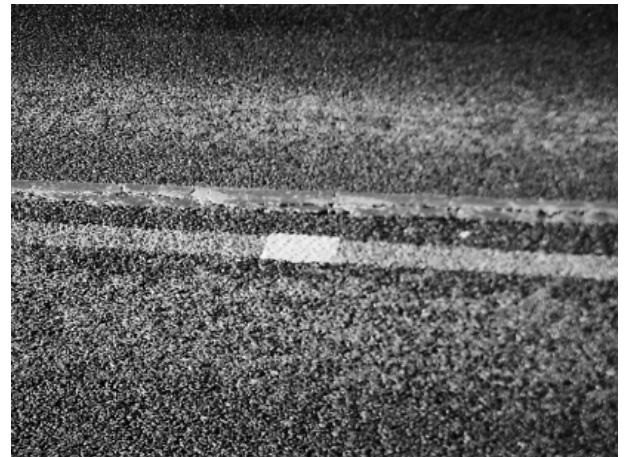
写真-4 高輝度反射テープ設置
